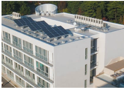
屋上設置状況
